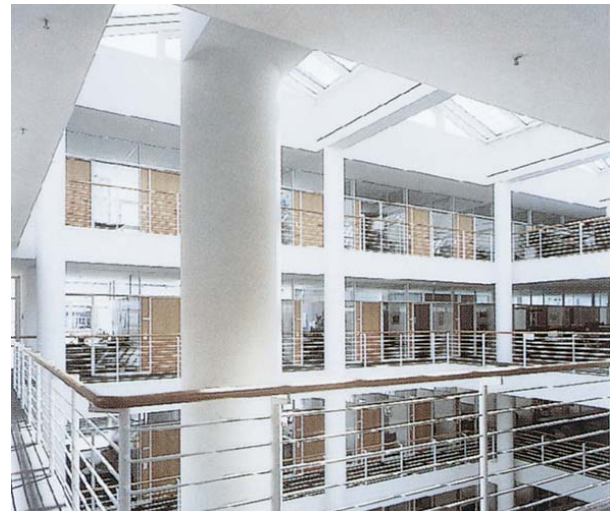
Bild 12: Oberlicht im Flurbereich
