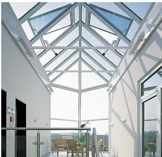
Bild 13: Oberlicht im Flurbereich
