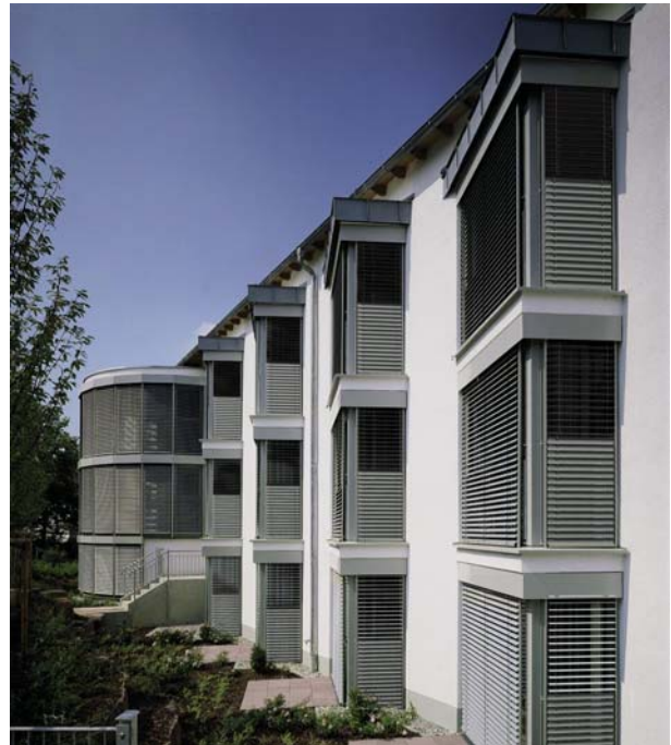
Bild 26: Sonnenschutz mit außenliegenden Lamellen
